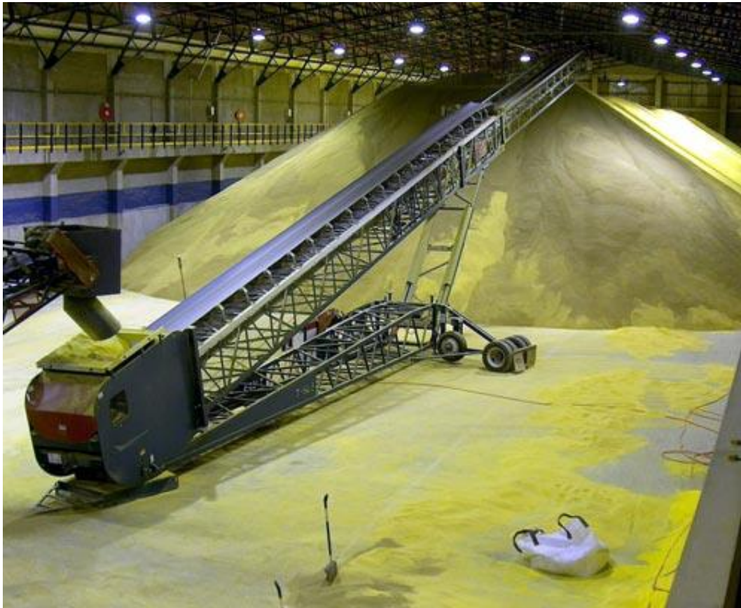
شکل (۷-۲) نمای داخلی یک نوع انبار مسقف گوگرد دانه بندی
